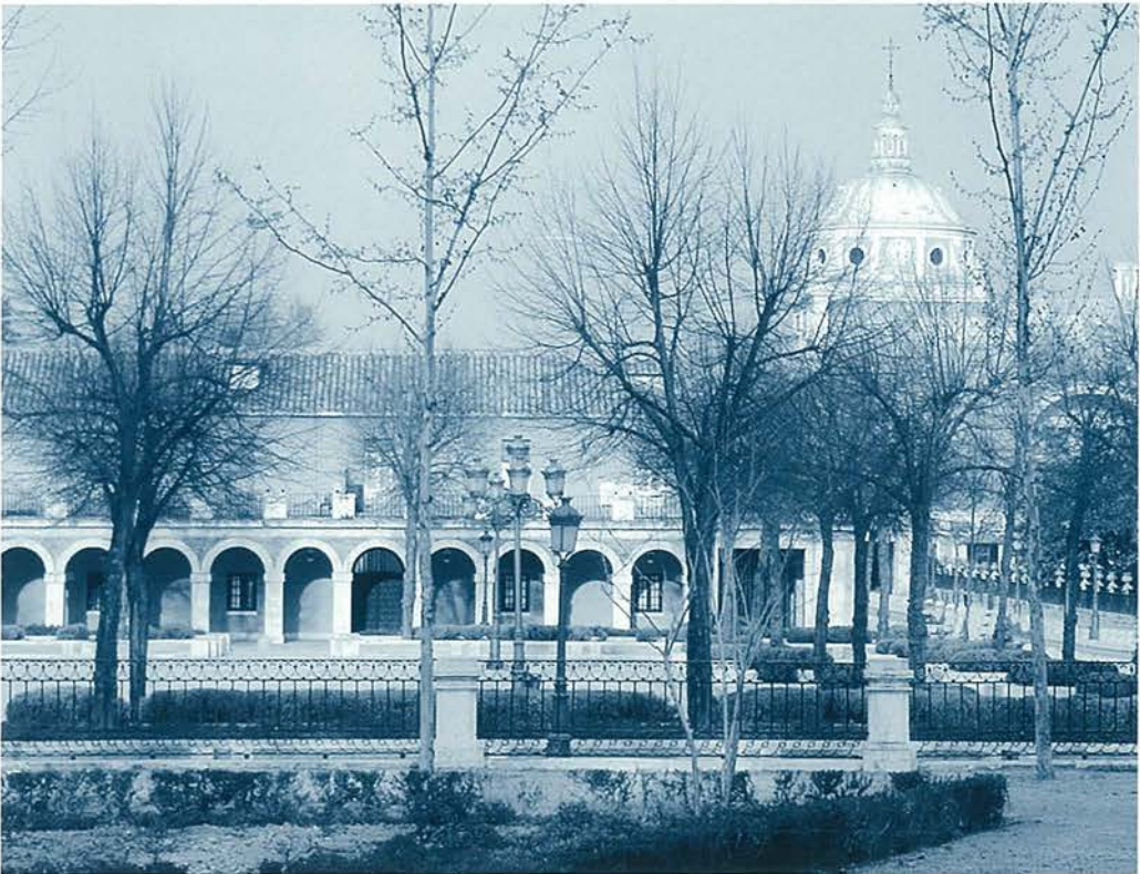
6. Palacio y Casa de Oficios.
